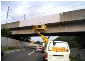
橋梁補修 (HBシート工法)
