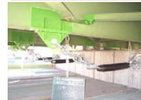
橋梁耐震補強 (緩衝チェーン)
