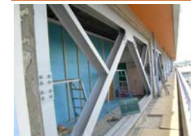
建築耐震補強 (接着ブレース)
